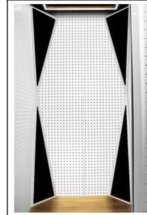
Les coins, la bête noire de l'acoustique. L'angle de 90 degrés, le plus néfaste entre 600 Hz à 20 Hz. Véritable amplificateur du grave. Il existe une solution efficace "Bas -Trap - Corner"
